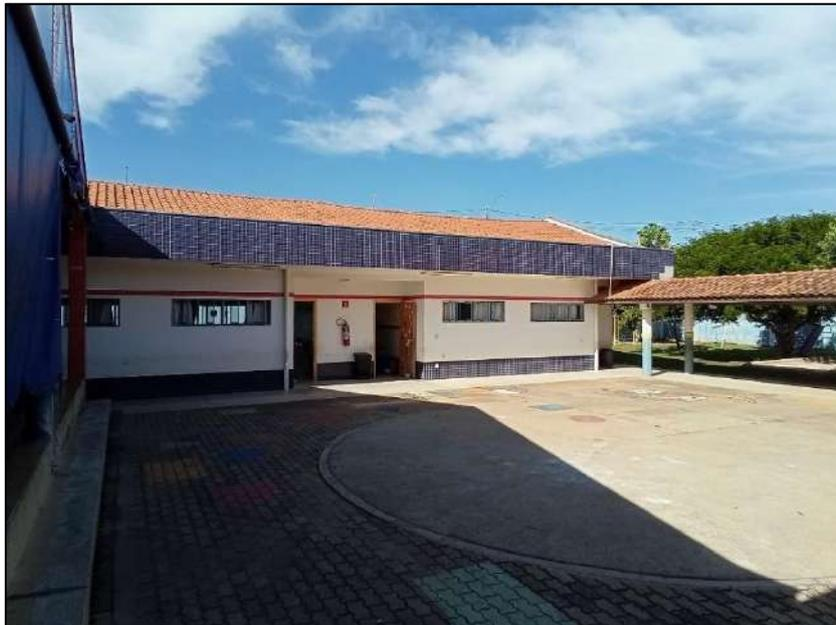
Desníveis no telhado proporcionam acúmulo de água, com reflexos na fachada e no aparecimento de fissuras.
