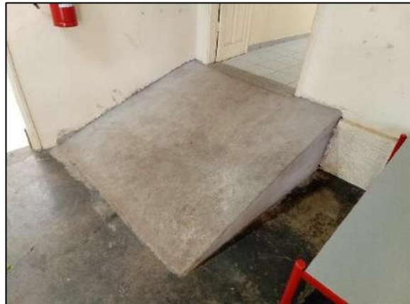
Os degraus existentes entre o refeitório e as salas de aula do Fundamental I foram retirados; porém, a rampa construída ficou fora das especificações técnicas legais (muito íngreme).
